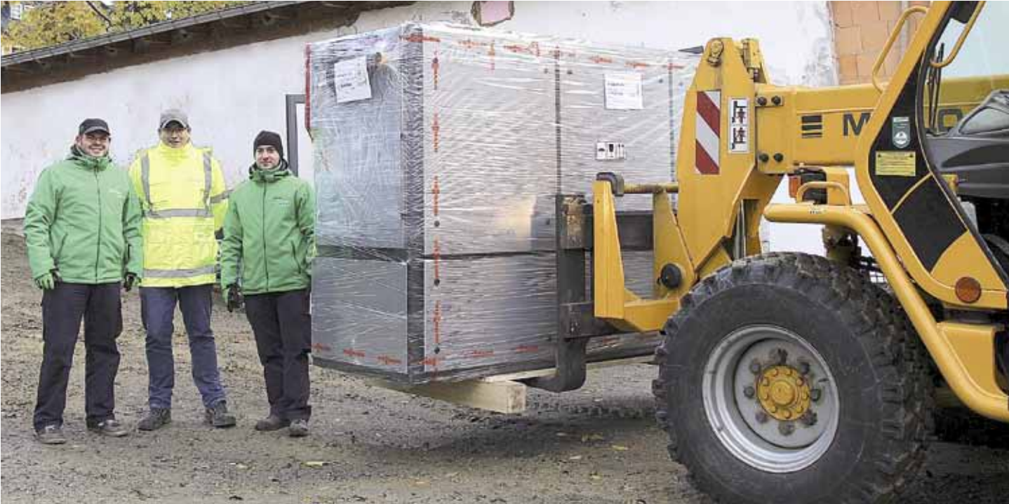
Stadtwerke-Mitarbeiter beim Abladen des 1. BHKW-Moduls für das Heizwerk im alten Stadtbad (großes Foto). Derzeit reichen die Fernwärmeleitungen bis hierher. 2017 erfolgt nun die Erschließung der gesamten Johannisgasse (Foto unten).
